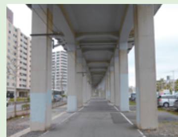
写真 2 海岸に近い高架橋の橋脚
