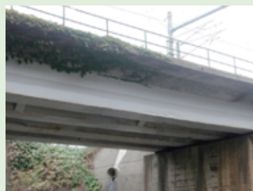
写真 1 海岸沿いの橋梁の桁
